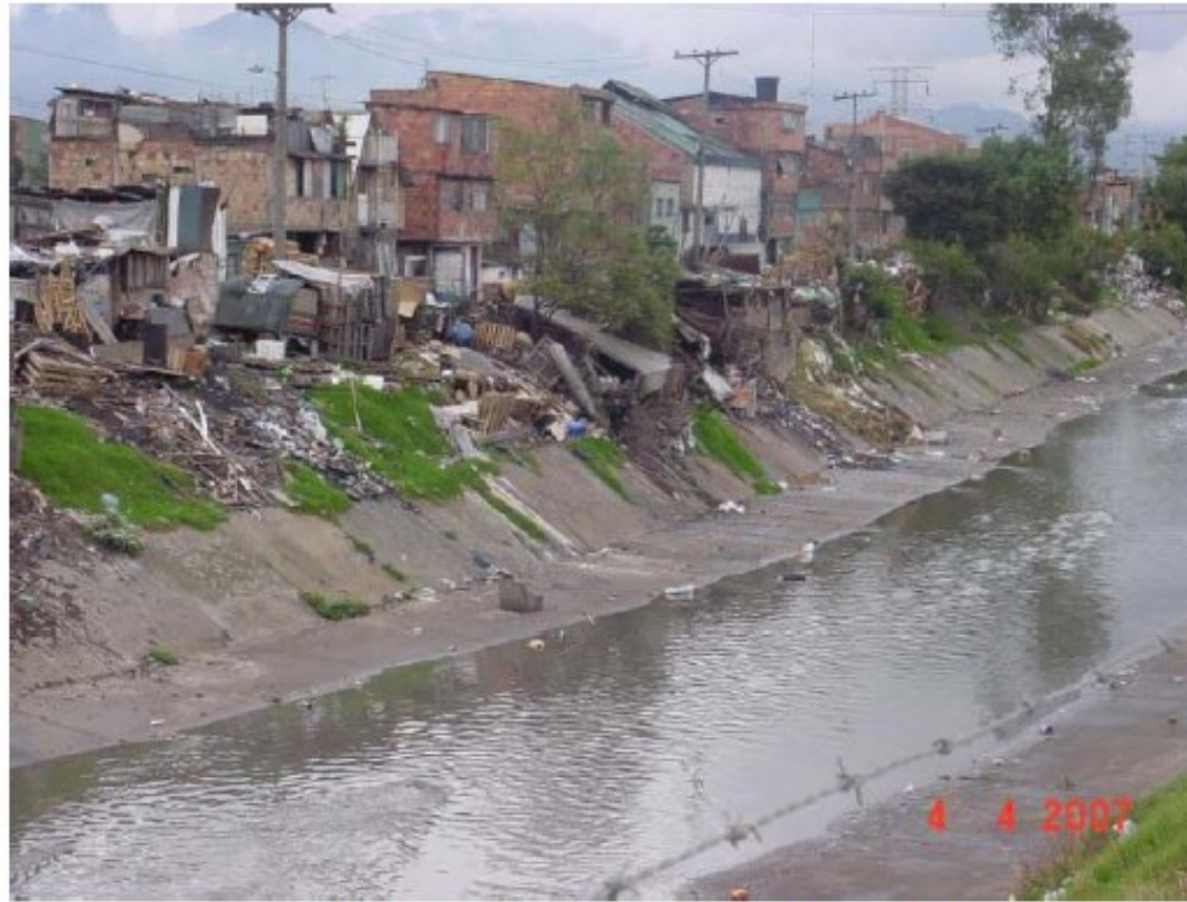
Río Fucha canalizado (Bogotá). Nótese la condición y contaminación ribereña
