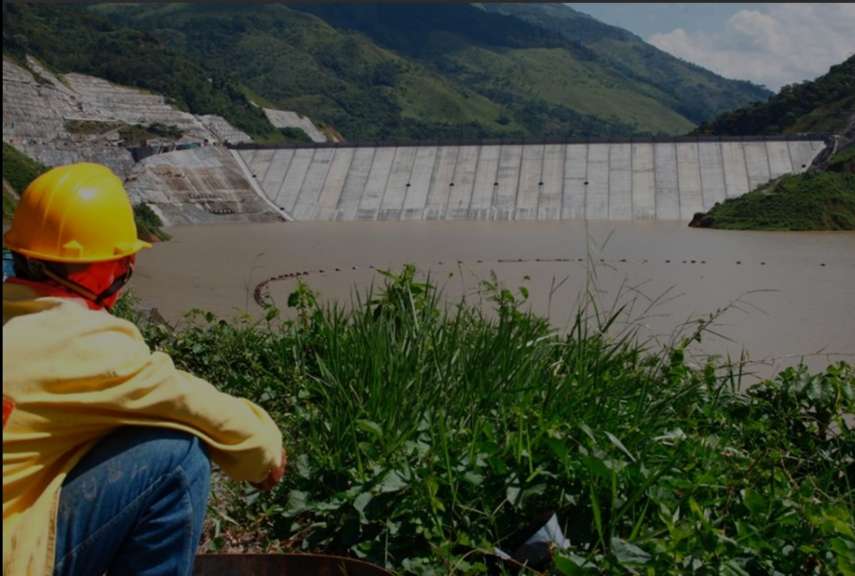
Todo el equipo de trabajo en la zona estaba pendiente de los detalles del llenado
