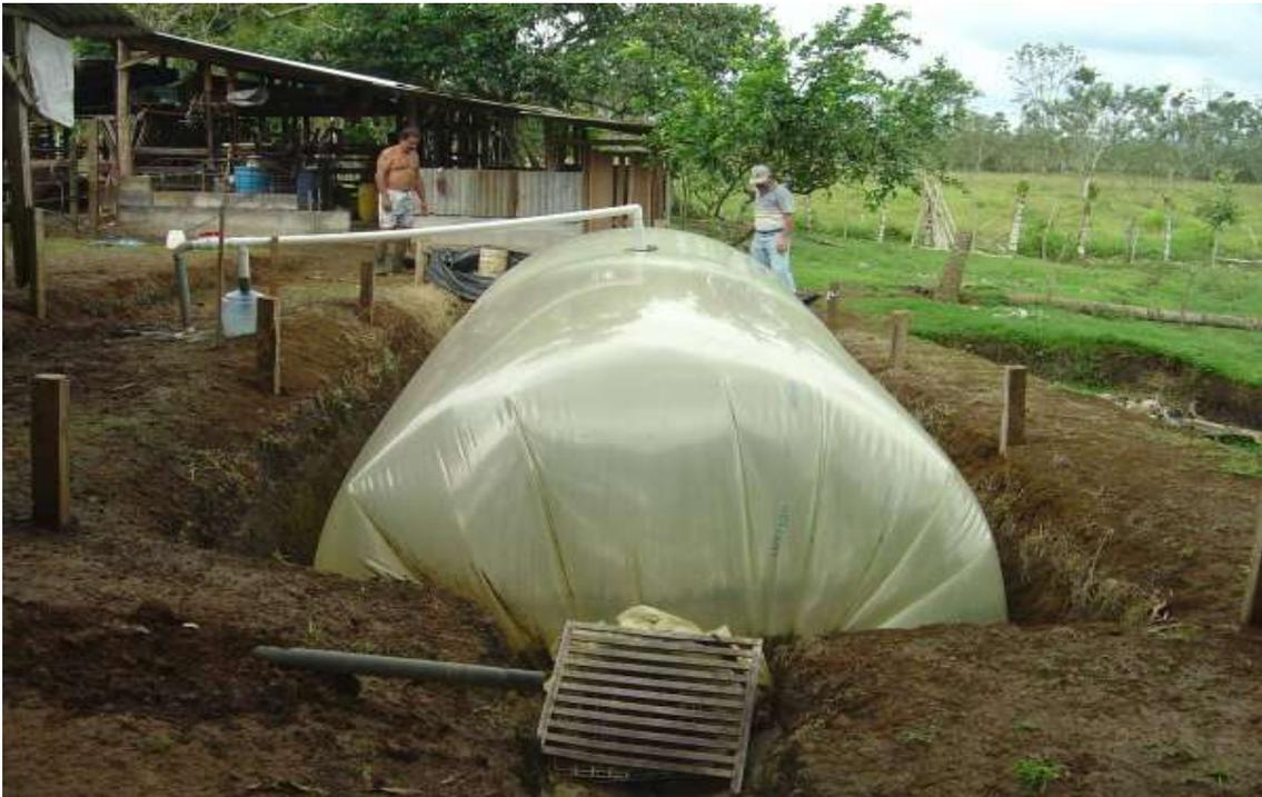
FIGURA 1b. Biodigestor en bolsa doble de polietileno de bajo costo, modelo Taiwán instalado y operando en una finca familiar.
