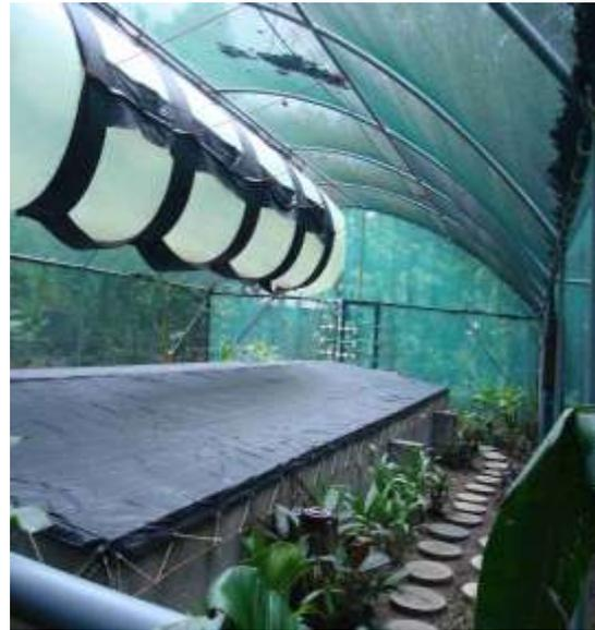
FIGURA 1c. Modelos de casetas para la protección de los biodigestores de tipo Taiwán y para muy diversas opciones adicionales de uso.
