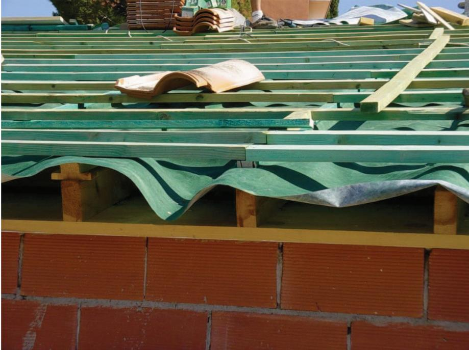
Sistema para impermeabilización de cubiertas mediante membrana anticonvección.
