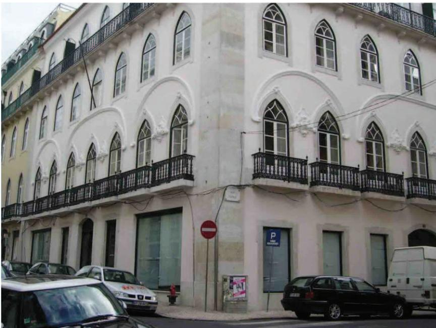
Fachadas exteriores en Lisboa realizadas con mortero de cal aérea. Correctamente aplicado la fisuración por endurecimiento no existe en la cal.
