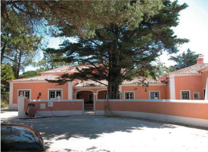
Morteros de cal pigmentados en masa con protección de silicato. Máxima elasticidad, plasticidad, transpirabilidad e hidrofugacidad en los exteriores.
