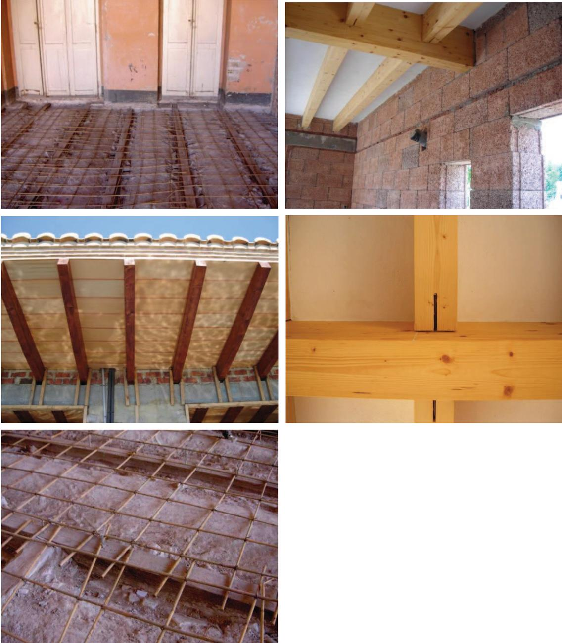
Sistema constructivo mediante estructuras de madera y de mallazo de bambú.
