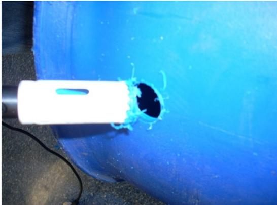
**Imagen 6. Perforación orificio de entrada**
