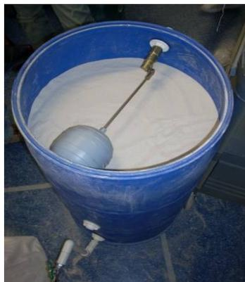
**Imagen 12. Instalación de la válvula de flotador**
