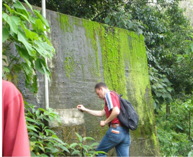
Imagen 2. Tanque de concreto de 30.000 L
