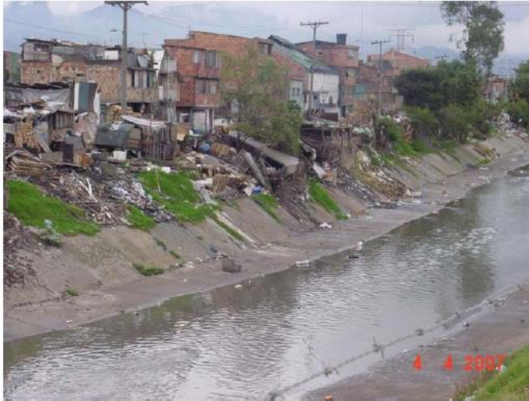
Río Fucha canalizado (Bogotá). Nótese la condición y contaminación ribereña
